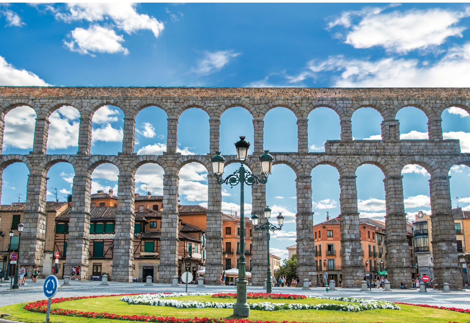
セゴビア旧市街と水道橋
